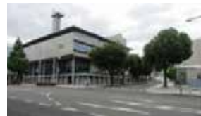
城下筋「県立美術館前」交差点付近
