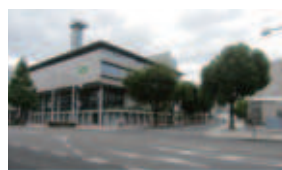
城下筋「県立美術館前」交差点付近
