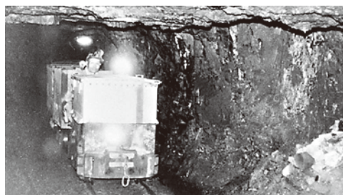
鉱業所坑内作業
